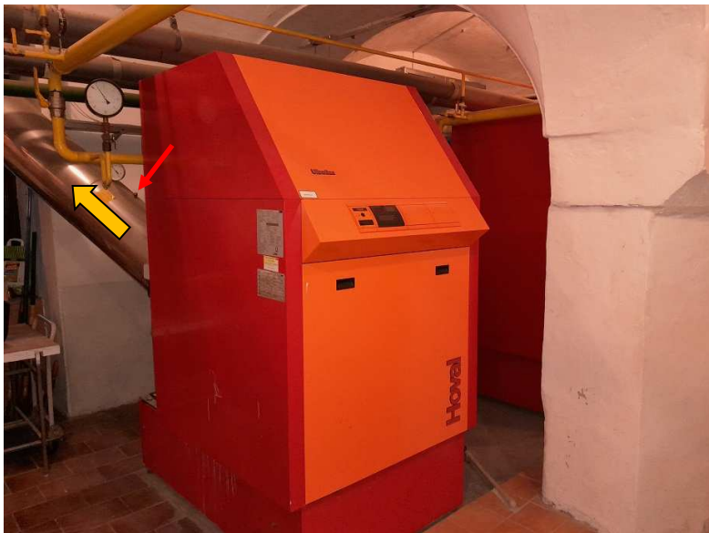
▲ Obrázok č. 1 – Miesto merania kotla K1 na spalinovom potrubí ← a smer prúdenia spalín →
