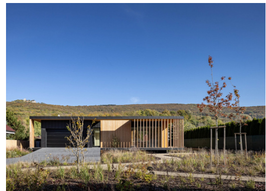
FIRMA KLOBOUCKÁ LESNÍ, S. R. O., V BRUMOVĚ-BYLNICI (MJÖLK ARCHITEKTÍ) (ZDROJ: BOYSPLAYNICE).
